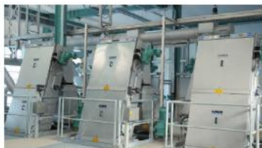
HUBER Multi-Rake Bar Screen RakeMax® - Thiết kế chắc chắn cho sự vận hành tin cậy.
