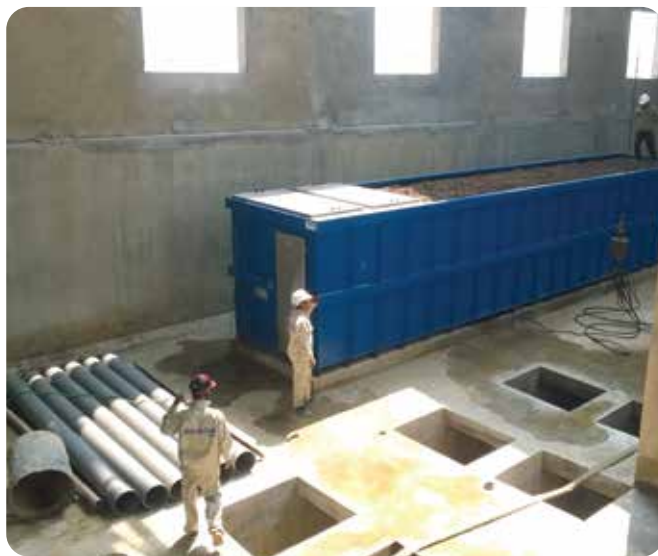
◆ Cung cấp và lắp đặt thiết bị công nghệ, cơ điện cho nhà máy xử lý nước thải thị xã Bỉm Sơn, tỉnh Thanh Hóa - CS Giai đoạn 1: 3500 m 3 / ngày (2016)
