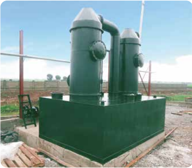
◆ Cung cấp và lắp đặt hệ thống khử mùi cho dự án Xử lý nước thải thành phố Ninh Bình, 2000 m 3 /giờ
