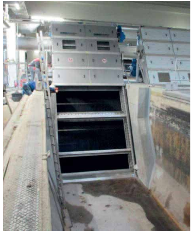
Multi-Rake Bar Screen RakeMax® Hybrid như thiết bị tách rác tinh với chiều rộng của máy là 3.2m
